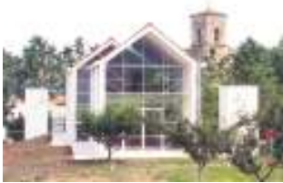
Lagasabaster Gomez etxea, 1991. Miguel Anjel Campo eta Roberto Ercilla. Irudi err ef.: Vitoria-Gasteiz. Guía de arquitectura, 202. or.
