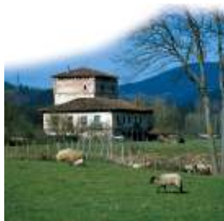
Murgatarren etxea. Aiara ibarra (A).
