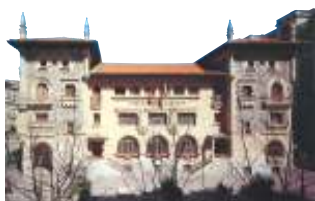
Posta eta Telegrafia etxea, 1922. Luis Diaz Tolosana. Irudi err ef.: Vitoria-Gasteiz. Gía de arquitectura, 93. or.
