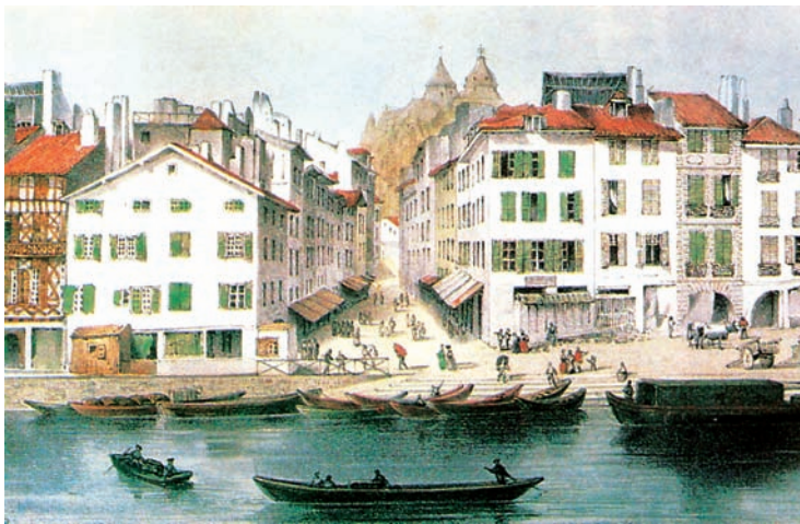
Baionako kaia, Errobi ibaian. Embarcadero en Baiona sobre el río Nive .
