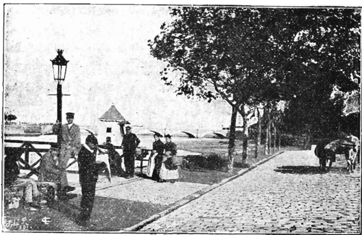
SAN SEBASTIÁN. -- Puente provisional de madera, a que sustituye actualmente el monumental de « Reina Cristina ».
