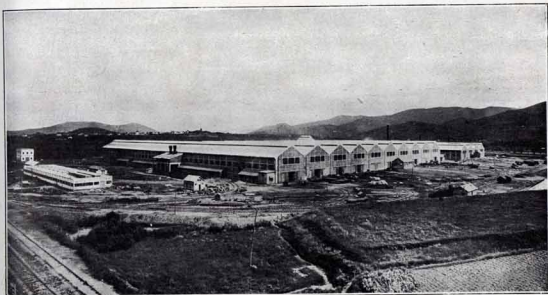
Vista general de la importante factoría Babcock Wilcox instalada en Sestao.—Fot. González
