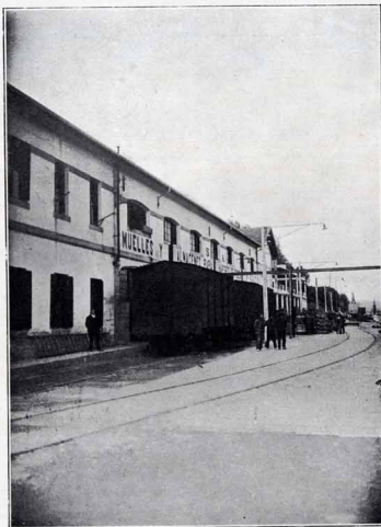
PASAJES. —Muelles y vía férrea particular de la S. A. «Muelles y Almacenes para Vapores de Pesca» que conduce a sus vagones frigoríficos de la estación del Norte
