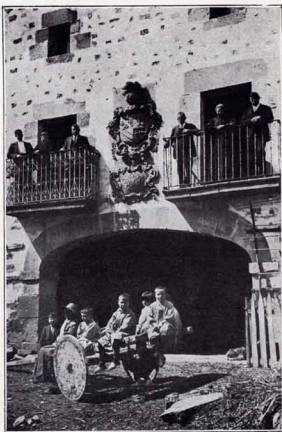
Portada de la Casa Solar "Zubleta" en Apatamonasterio. F. Ojanguren
