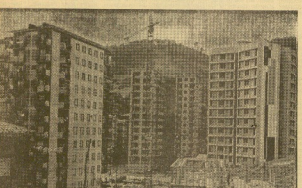
Un aspecto del conjunto labo-ratorio de este industrial barrio de Trinchere en sus modernas construcciones. Al fondo, el antiguo U.S.A.
