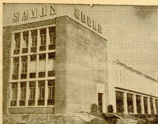
Vista parcial del edificio
