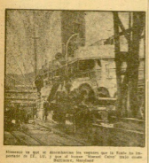
Edificio en el que se fabricarán los vagones que el Estado ha encomendado a las empresas de ferrocarril de los Estados Unidos
