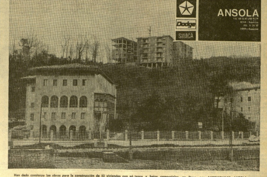
Han dado comienzo las obras para la construcción de 53 viviendas con sótanos y bajos comerciales, en Deva, por AUTOMOVILES ANSOLA.
