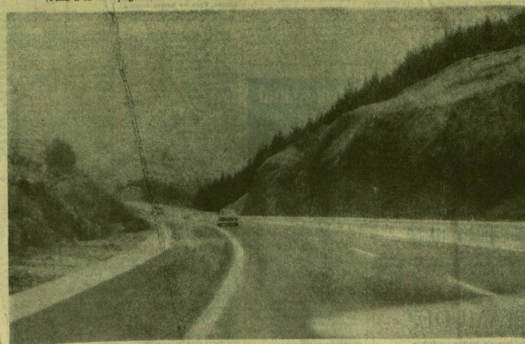
Nuevo tramo de la autopista que enlaza Ermua-Alzola a través de doce kilómetros de angosto y costoso recorrido, aunque desde la propia autopista no se pueda apreciar la realidad de las dificultades que ha supuesto su construcción. (Foto Pemán.)
