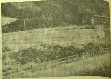
Obras que se realizan en la zona de Chertre para el nuevo campo de fútbol.
