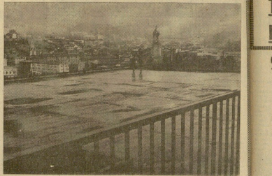
Plataforma de cemento sobre la que irán las estelas discólicas. Al fondo, Oñate.
