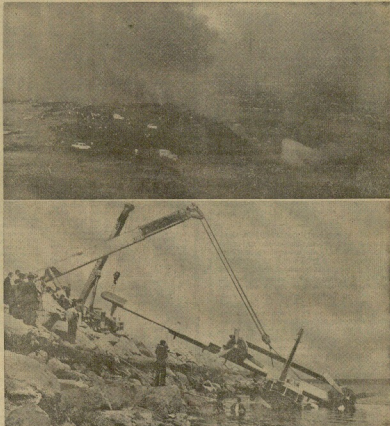
Arriba, un aspecto del incendio en el Jaizkibel, y abajo, el grúa trata de sacar el hidroturbina accidentado (Fotos PEMAN)
