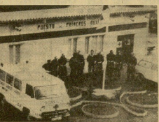
El hijo instalado un nuevo pabellón de socorro de la Cruz Roja en Urbión y que atenderá a la zona del Alto Gobiérn. En la fotografía, detalle del centro así su fachada.
