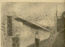
Foto 76. Fabricación de la sala de vigas de 23 metros para el viaducto. (Foto I. Linazasoro.)
