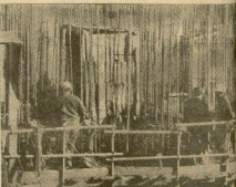
Foto 76. Trabajando en la construcción de un pilar del viaducto de Igaradua. (Foto I. Linazasoro.)
