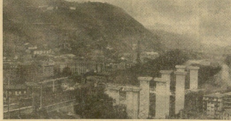
Noviembre 76. Los diez pilares y sus capiteles concluido. Se inicia el lanzamiento de las vigas. (Foto I. Linazasoro.)
