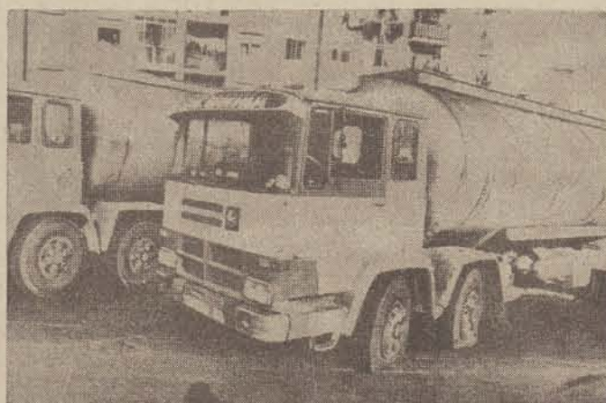
Ruedas pinchadas y vehículos atravesados son algunas de las acciones de los piquetes que actúan contra los transportistas que no secundan la huelga de este sector en Vizcaya. (Foto Efe)
