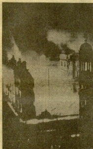
Un aspecto del gigantesco incendio que se declaró ayer tarde en el edificio "Palacio de Maeho", de Santander, donde existían el centro comercial de la firma "Manuel Lains" y algunas viviendas particulares. (Cifra Grafica).
