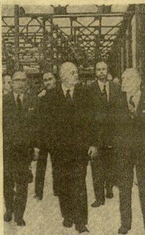
El ministro de la Vivienda, acompañado de las autoridades, durante su visita a las obras de ampliación del Instituto Politécnico de Valencia, que tendrá una capacidad para 12.000 alumnos. (Foto Ojeda).
