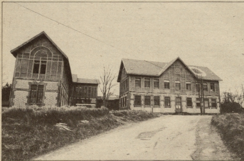
Actuales instalaciones de Zorroaga.
