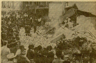
MEJICO. — Un terremoto sismológico siempre se ha producido en el mismo centro de la capital federal, causando graves daños. Marcha silenciosa fueron destruidos, produciendo después graves hundimientos, sacudió de nuevo a Méjico. Las fotografías del terremoto se exhiben en pensar sus beneficiarios auxilios de socorro a las víctimas. (Epi Telefoto)
