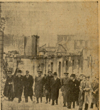
EL MINISTRO DE OBRAS PUBLICAS EN SANTANDER El Ministro de Obras Públicas examina los daños causados por el terremoto en Santander. (Foto Cifra.)
