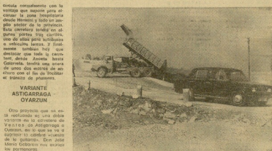
Las obras están en plena actividad. Comisiones especializadas proceden al retiro del terreno para conseguir la anchura prevista para la calzada y una acera de peatonal.
