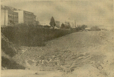
En la zona hospitalaria se aprecian fácilmente las obras de retiro que se están llevando a cabo para la nueva carretera. En este lugar un habitará también un aparcamiento para unos 500 vehículos.
